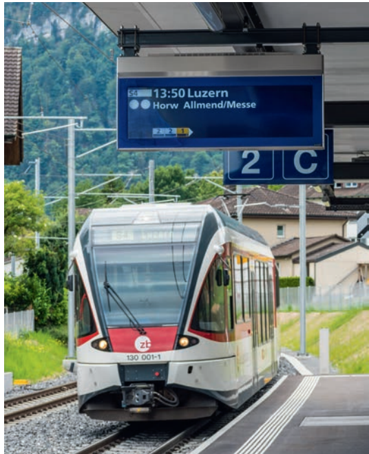
Abb. 4: TFT-Überkopfanzeiger, Zentralbahn AG
